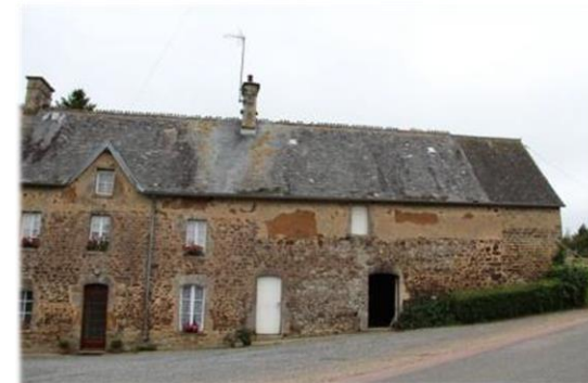
Une adaptation au terrain des constructions anciennes
