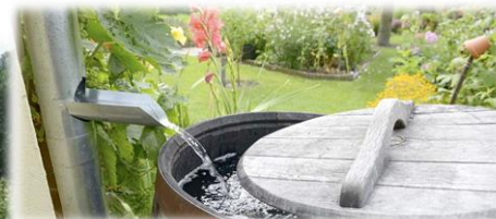
Systèmes simple de récupération réutilisation des eaux de pluies en descente de gouttière.
