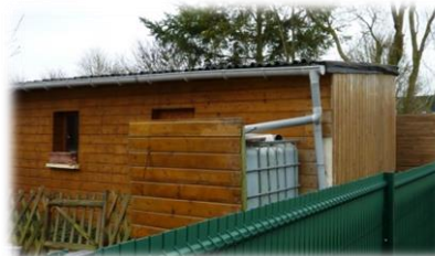
Systèmes simple de récupération réutilisation des eaux de pluies en descente de gouttière.
