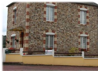
Eviter les teintes qui contrastent avec les matériaux traditionnels
